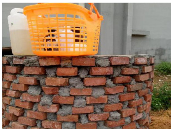
生活污水采样口
