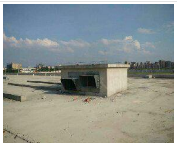
厨房油烟排放口
