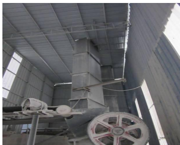
破碎车间密闭处理
