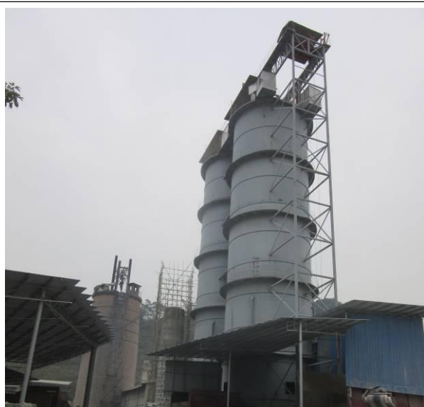
扩建项目新增的 2 座石灰炉窑
