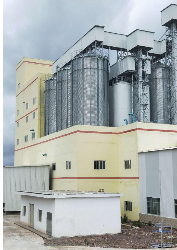
项目厂区全景
