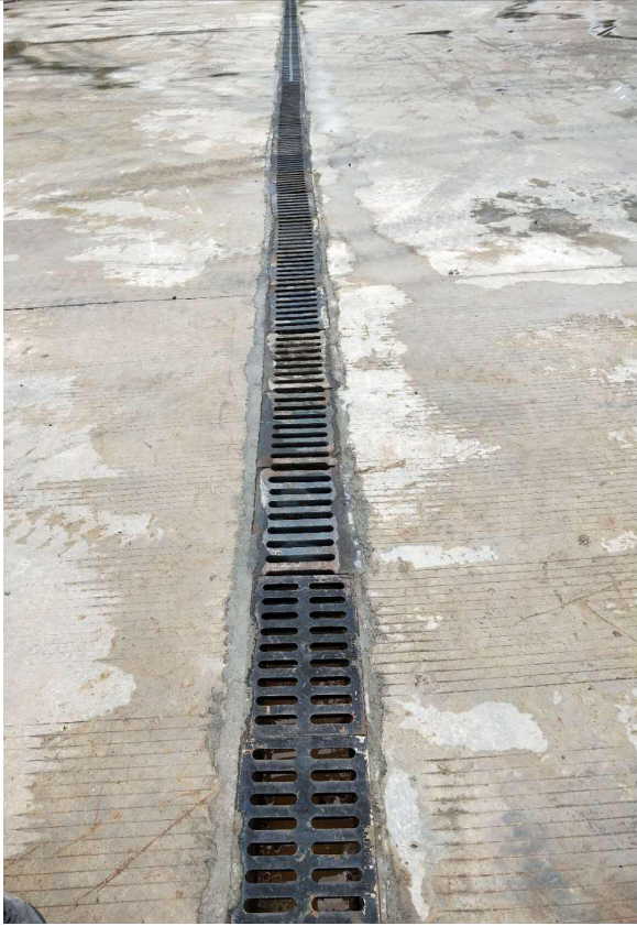
项目厂区雨排水沟
