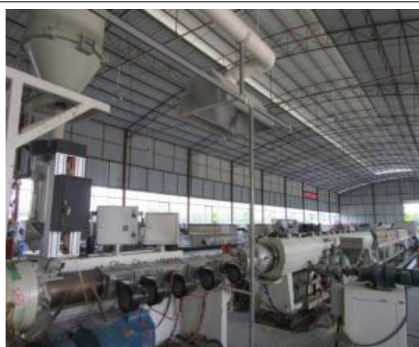
生产车间现状
