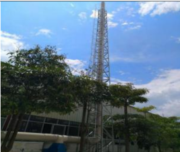
18m 高排气筒
