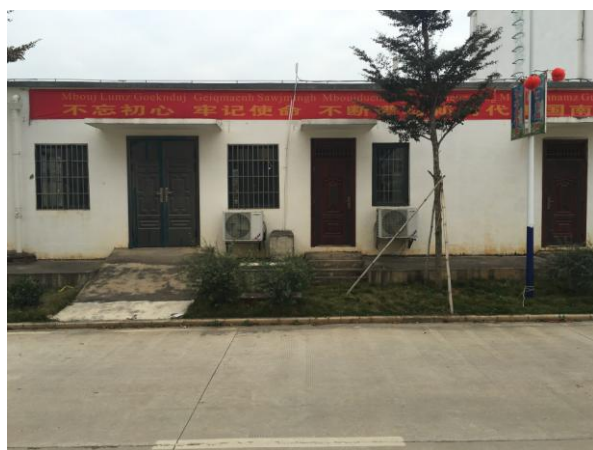
污水处理设备房
