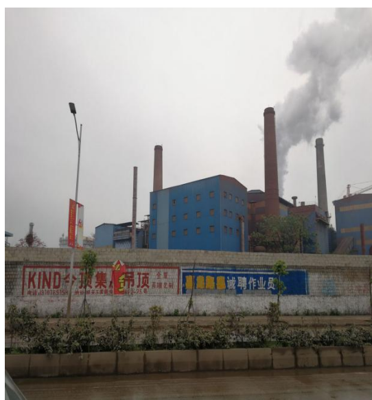
烧结生产系统架高围墙隔音措施
