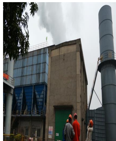
炼钢转炉除尘器
