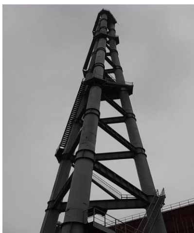
高炉煤气放散处理措施
