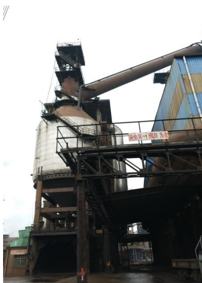
1080m3 高炉重力除尘器
