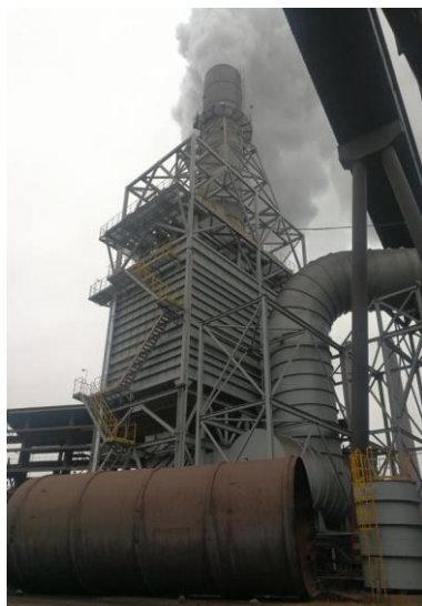
烧结机头烟气湿式除尘器
