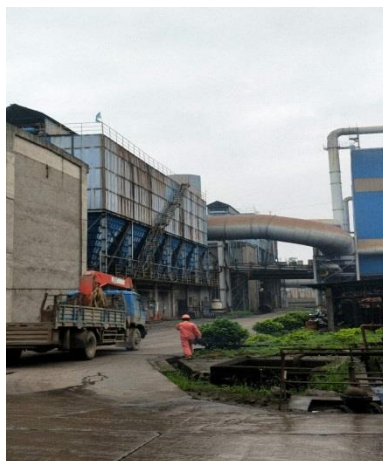
炼钢转炉除尘器
