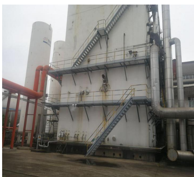
制氧间封闭隔音措施
