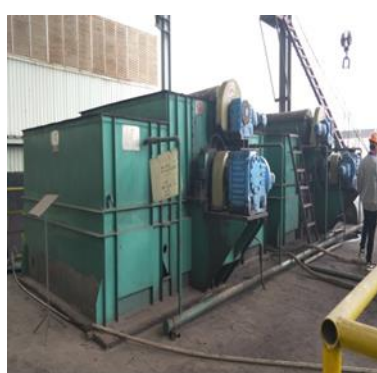
废水处理设施（稀土磁盘分离器）
