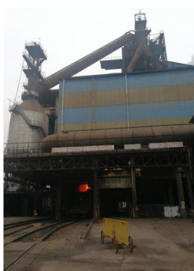
炼铁高炉煤气净化设施
