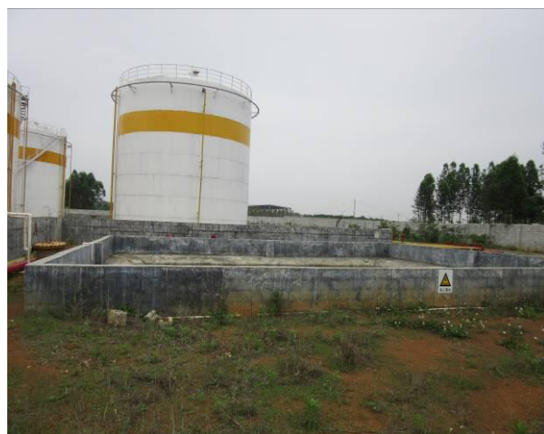
罐区事故应急池
