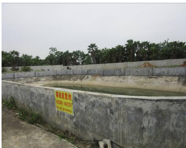
事故应急池（3000 立方）
