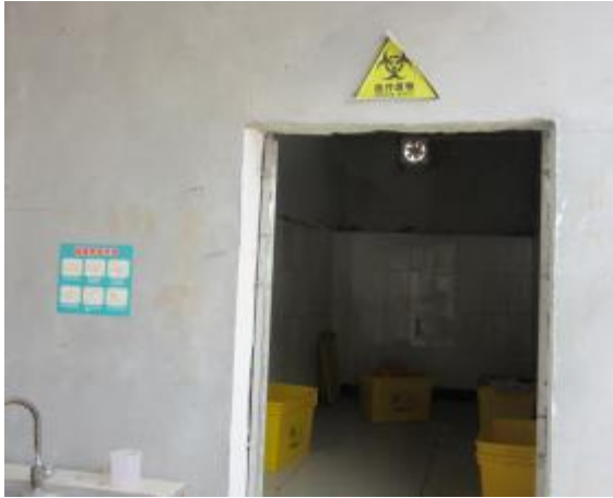
医疗废物暂存间
