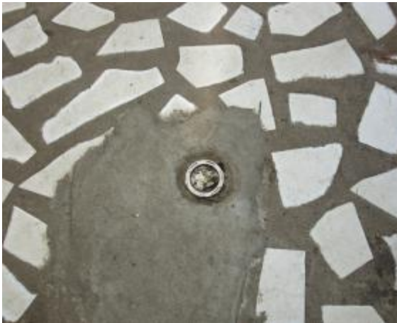
地埋式生化污水处理系统消毒池进水口
