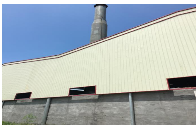
生产车间排气筒
