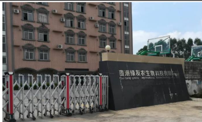
厂区大门及办公楼
