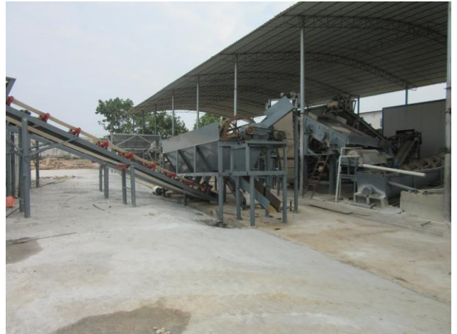
厂区二级破碎和筛分车间现状
