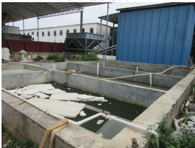
二次水洗沉淀池
