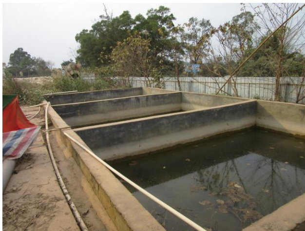
一次水洗废水沉淀池、雨水收集池
