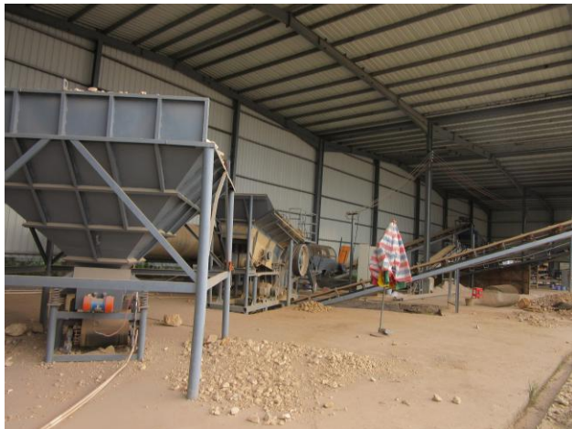
厂区一级破碎和筛分、一次水洗车间现状
