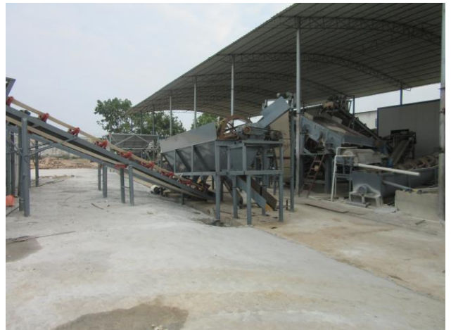
厂区二级破碎和筛分车间现状
