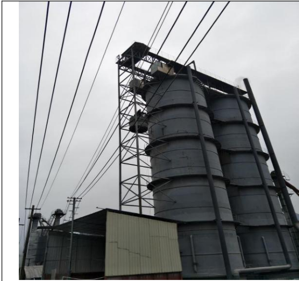
扩建项目新增的 2 座石灰炉窑
