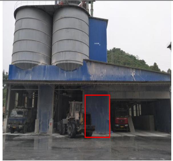
破碎车间密闭处理
