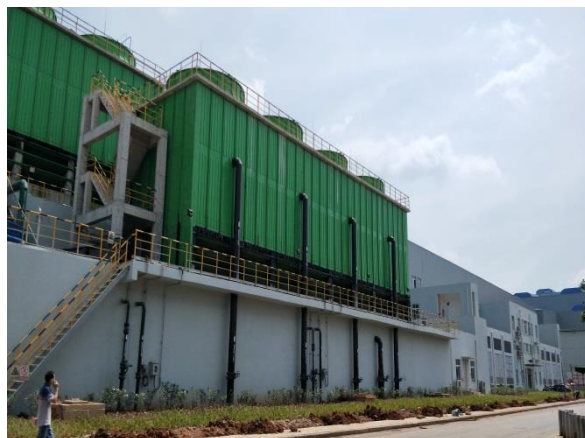
废水处理设施 2
