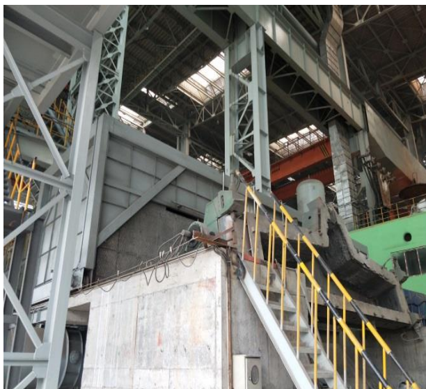
翻罐、修罐集尘
