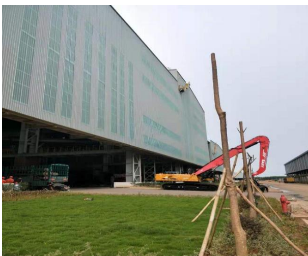
厂房封闭、植树、绿化
