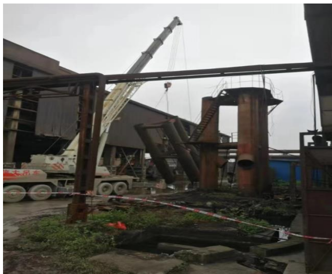
35t 炼钢转炉拆除现场图 4
