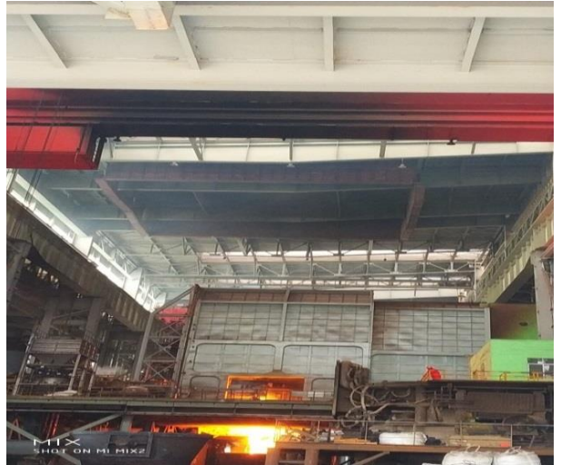
电炉密闭罩+屋顶罩
