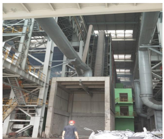
散状料密闭输送带+投料口集尘罩
