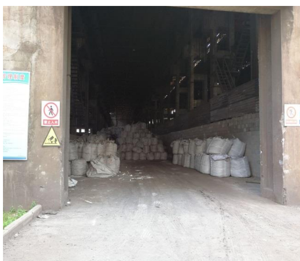
35t 炼钢转炉拆除后现状图
