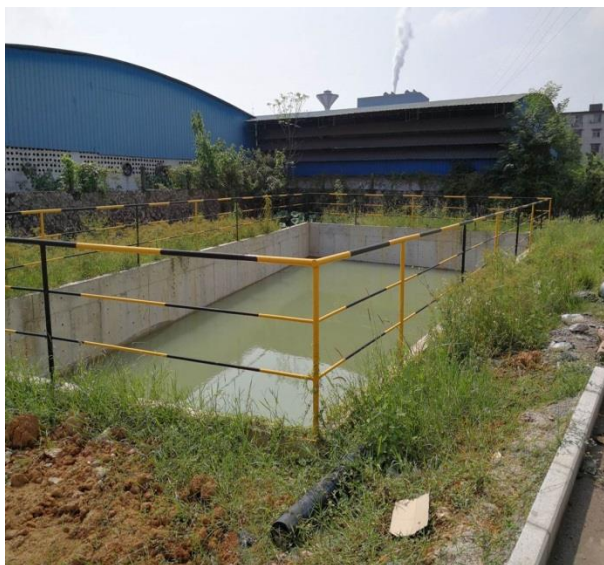
初期雨水收集池
