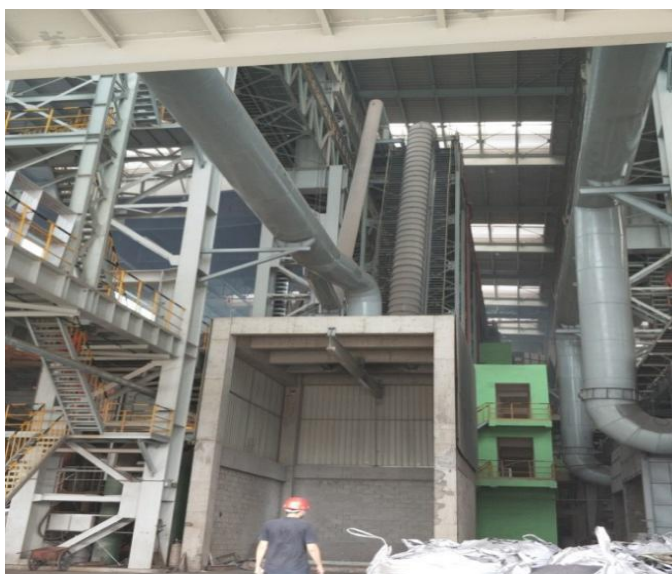
散状料密闭输送带+投料口集尘罩
