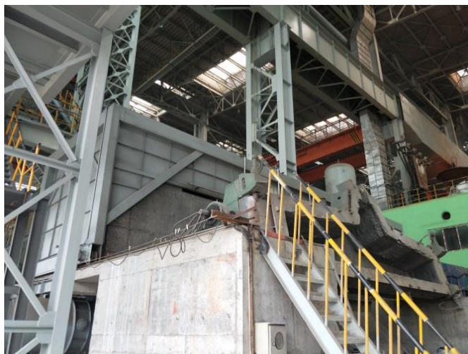
翻罐、修罐集尘
