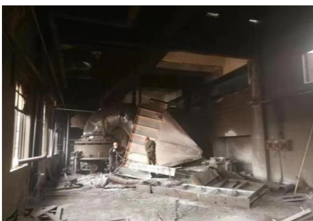
35t 炼钢转炉拆除现场图 1
