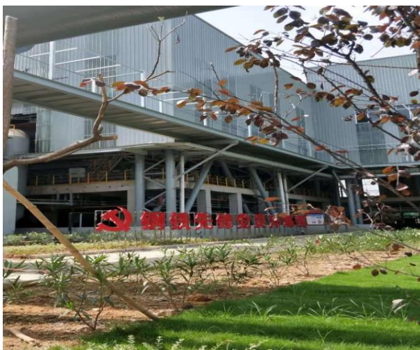
厂房封闭、植树、绿化
