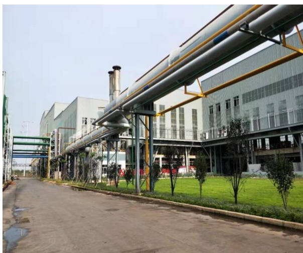
厂房封闭、植树、绿化
