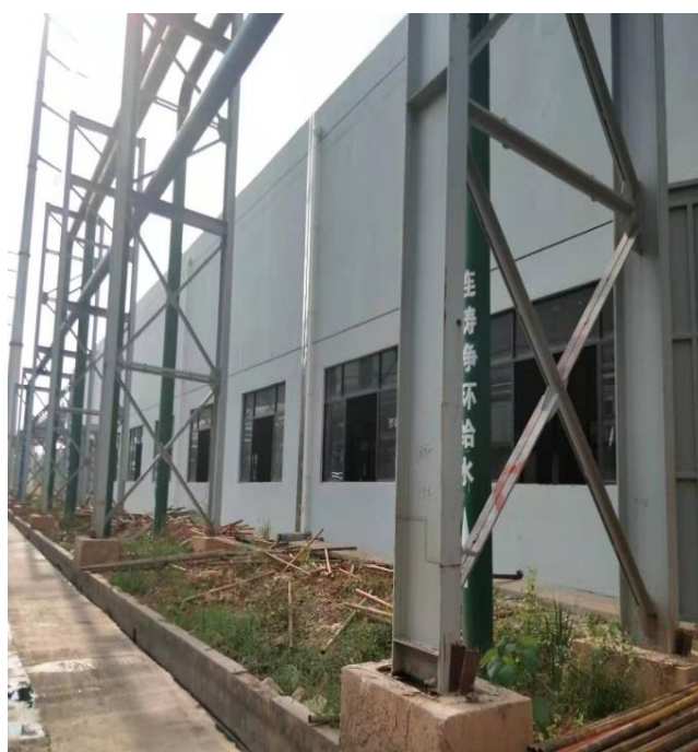
密闭的循环水泵房
