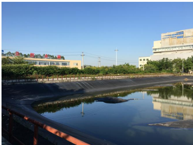
调节池（膜下部为渗滤液，图片显示的为雨水）
