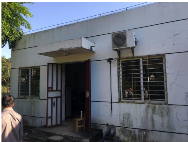
膜处理间外部（监控室）
