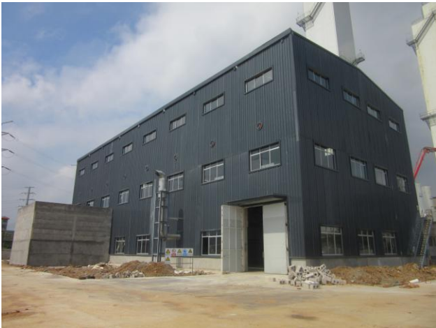
主厂房（安装空压机、氮压机、氧压机）
