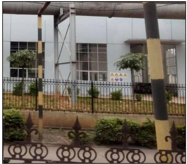
危废暂存间外部
