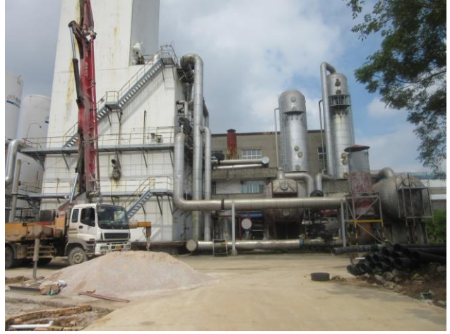
西面（原有一期空分装置区）
