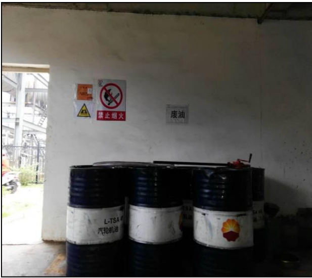
公司危废暂存间内部
