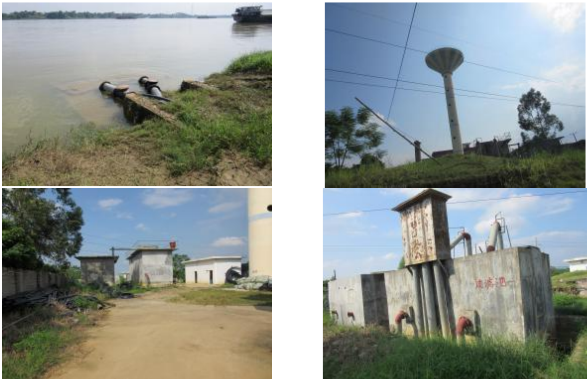
图 3.1 峰珠岭取水口及水厂现场踏勘照片
