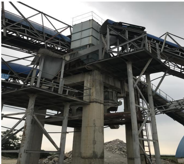
二级破碎脉冲式布袋除尘器（无排气筒）
