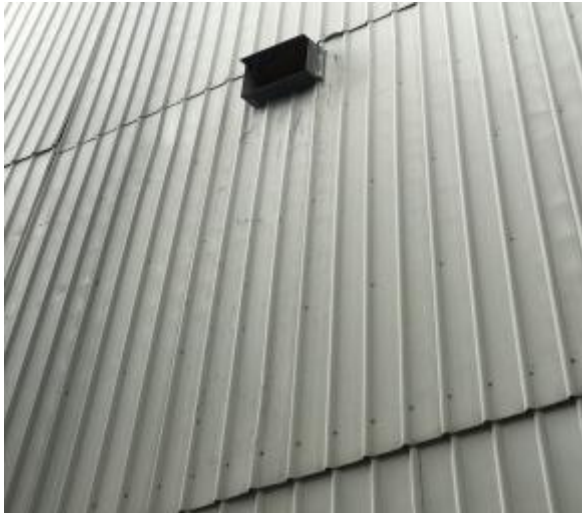
白石粉生产线立磨工艺磨头布袋除尘器排 气筒
