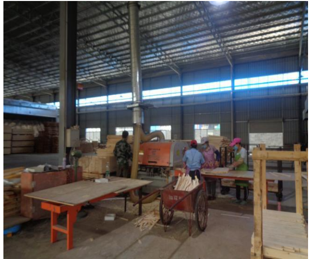
车间粉尘吸尘软管 2
