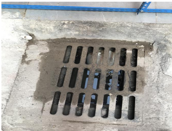
医疗废水排放口
