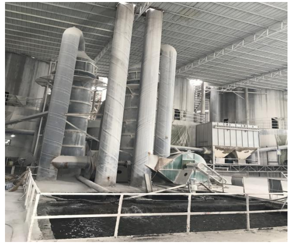
5号窑旋风+水膜脱硫器
