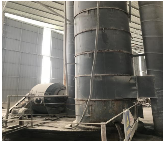
3、4号窑旋风+水膜脱硫器
