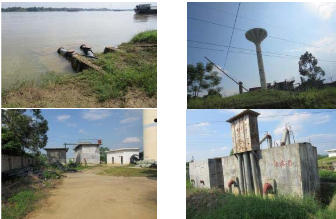
图 3.1 峰珠岭取水口及水厂现场踏勘照片
