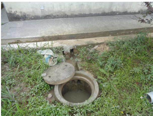
2号仓库的雨水沟及雨水排放口
