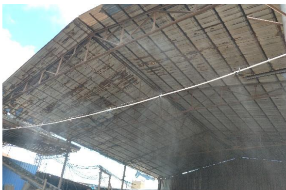
破碎线喷淋降尘
