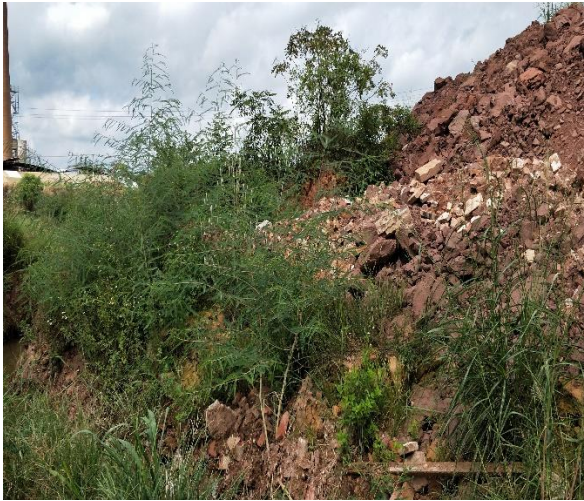
矿山边坡防护
