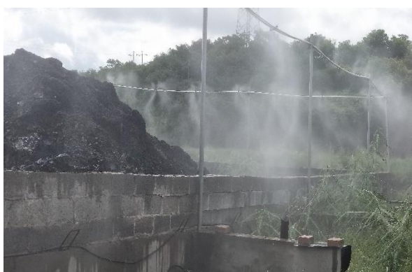
煤堆围挡及喷淋降尘
