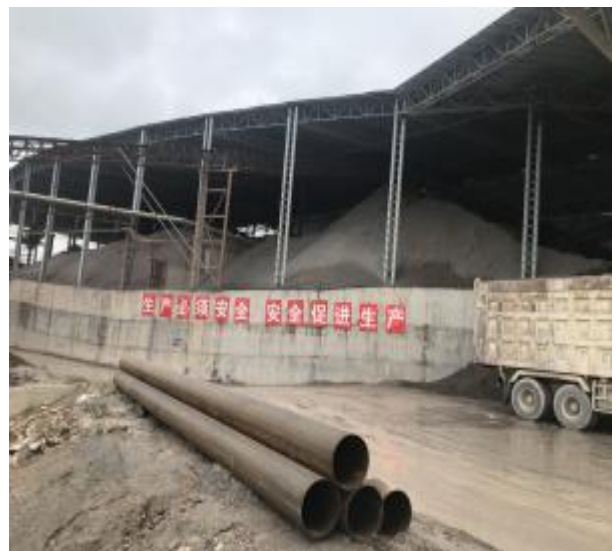
碎石生产区成品堆场
