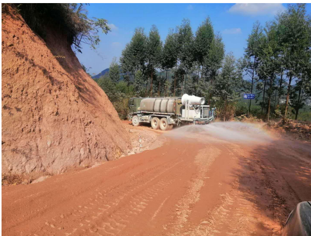
矿区进出道路
