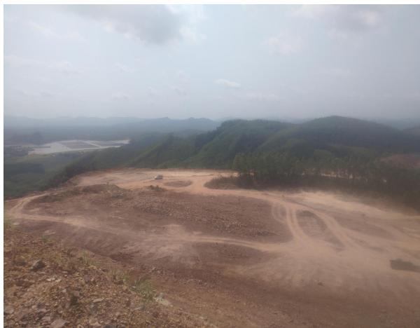
场区四周排水沟
