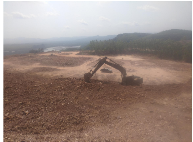
场地堆土平整现状
