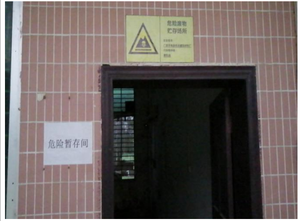
危险废物暂存间
