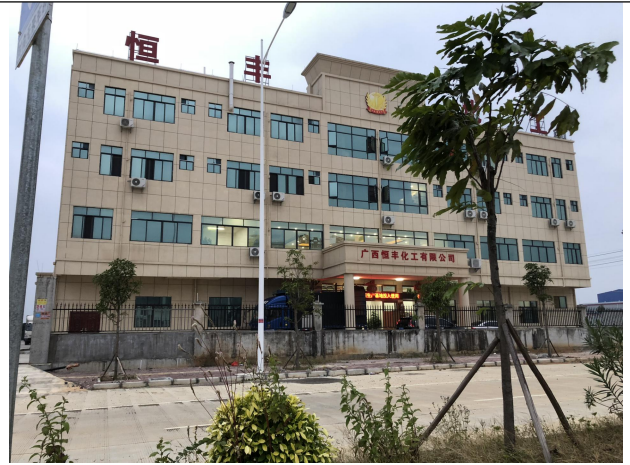
建设项目东北面恒丰化肥
