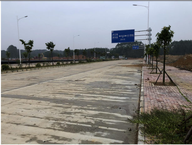
建设项目东南面创业大道
