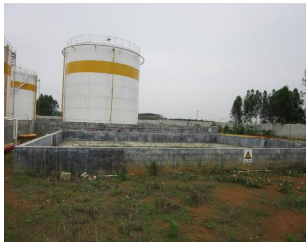
罐区事故应急池
