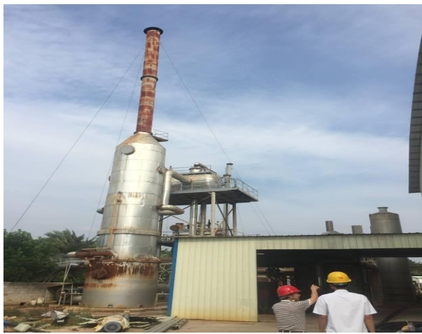
1#尾气锅炉（已验收通过）
