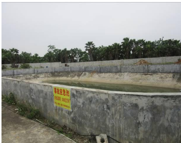
事故应急池（3000 立方）
