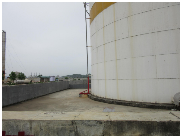
甲醛罐区围堰
