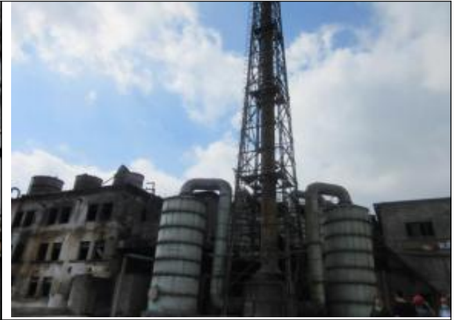
磷肥车间外部现状
