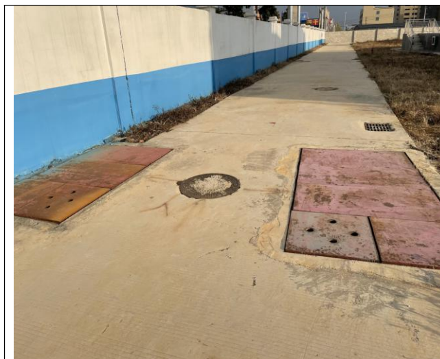
雨水、污水外排口（氨水罐区东北面）
