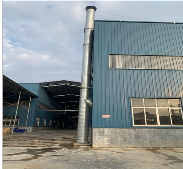
热压废气排气筒 2
