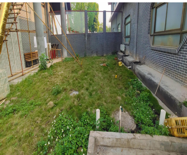
地埋隔油沉淀池
