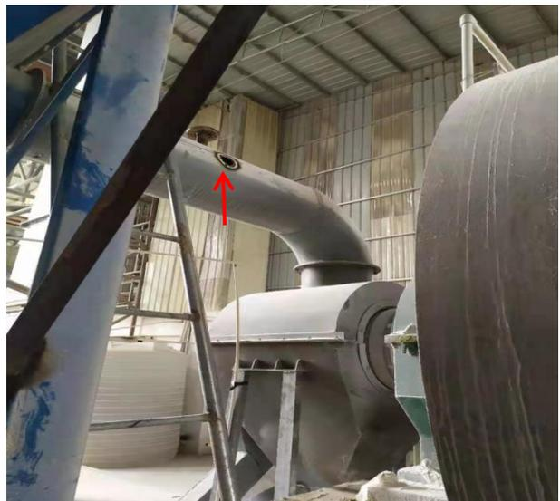
2#磨球破碎布袋除尘器进气口（监测点）
