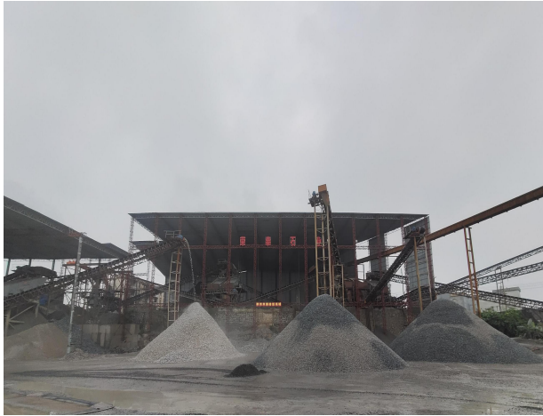
出料临时堆场
