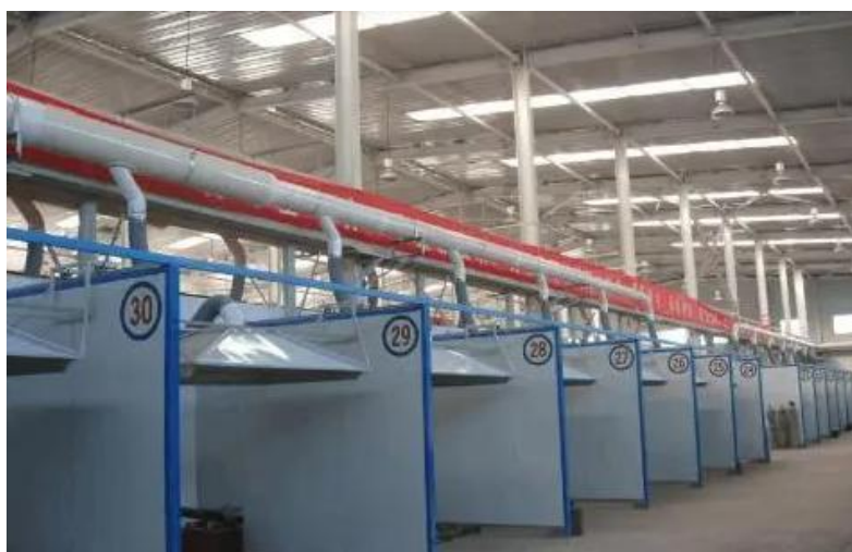
图 5.2-1 焊接烟尘收集
