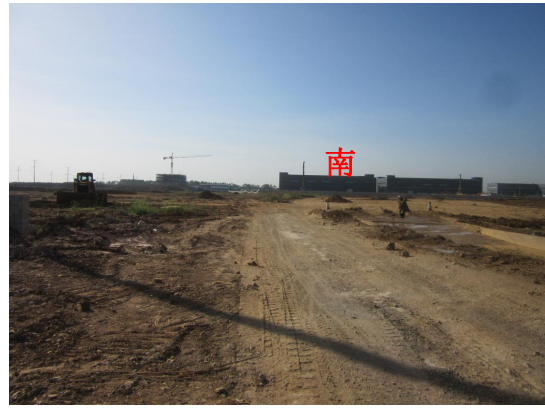
项目场址概况 2
