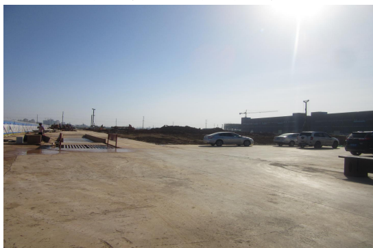
项目南面在建工地
