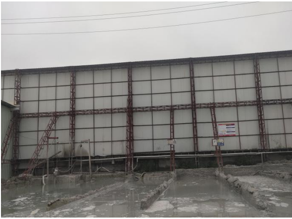
运输车辆清洗废水、雨水收集沉淀池
