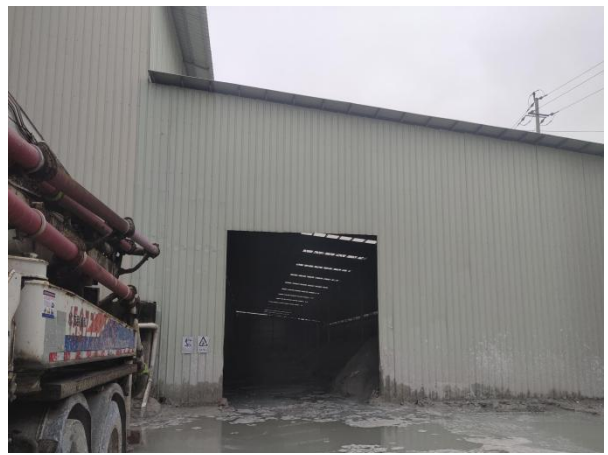
沉淀废渣堆场
