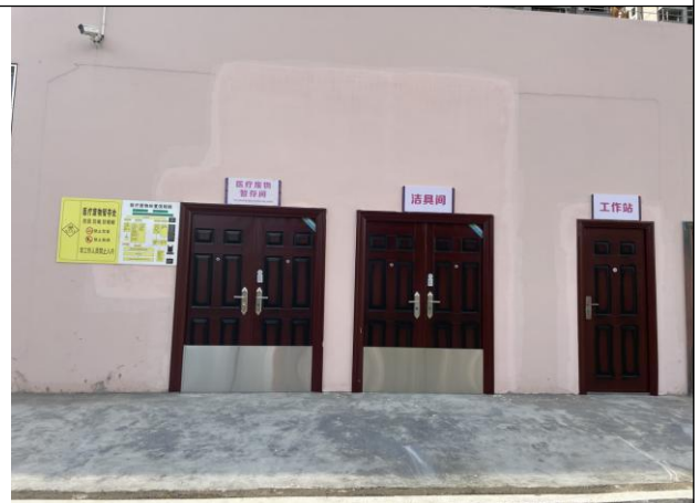
医疗废物暂存间、洁具间、工作站
