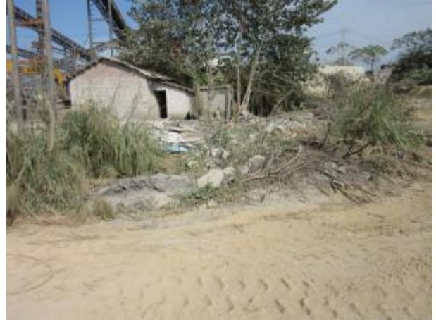
三级化粪池所在地
