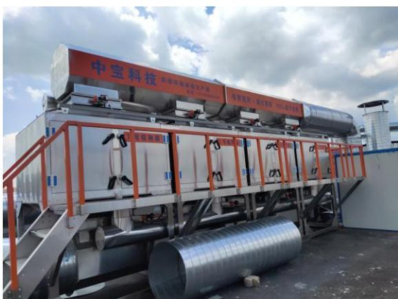
自动喷漆线（水帘式净化器+干式过滤器+三级活性炭吸附浓缩+催化燃烧装置）中的活性炭吸附装置
