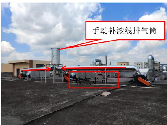
手动补漆线（三级活性炭处理装置，单个喷漆房每3套共用一根排气筒）
