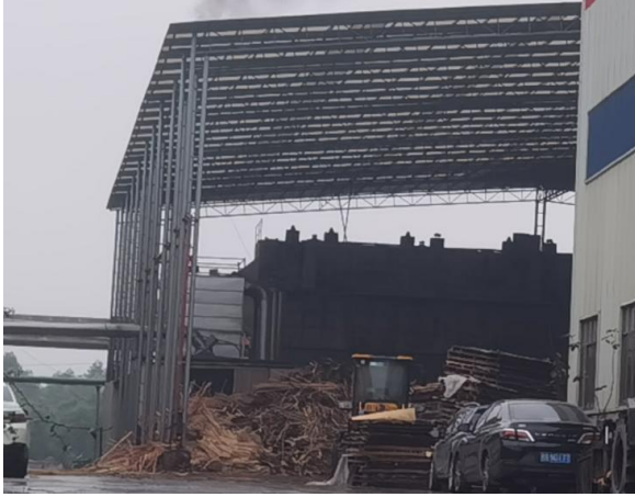
本项目生物质锅炉房
