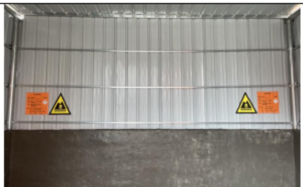
危废暂存间内部
