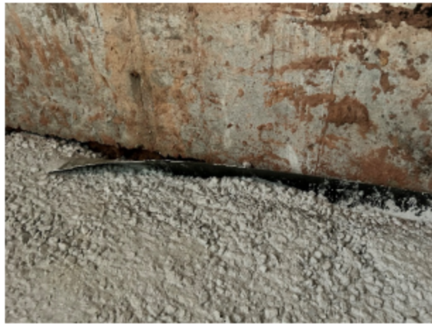
2、3线替代原料仓内部（硬化、防渗处理）
