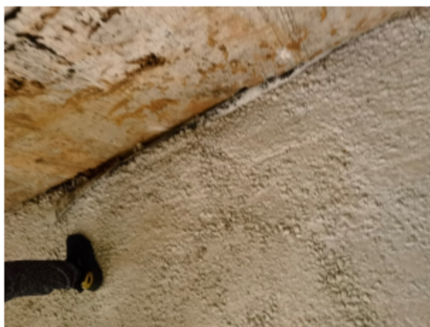
4、5线替代原料仓（硬化、防渗处理）
