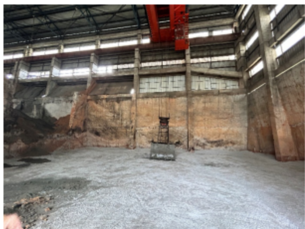
4、5线替代原料仓内部
