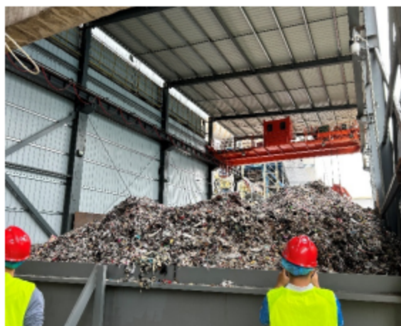
3线燃料替代仓库
