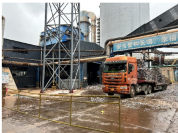
2线燃料替代仓库
