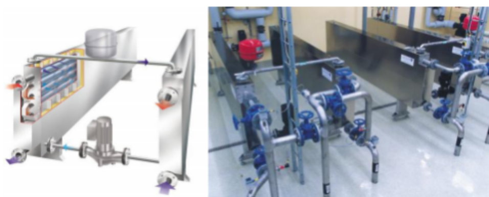
泥水换热器原理示意图及实景图
