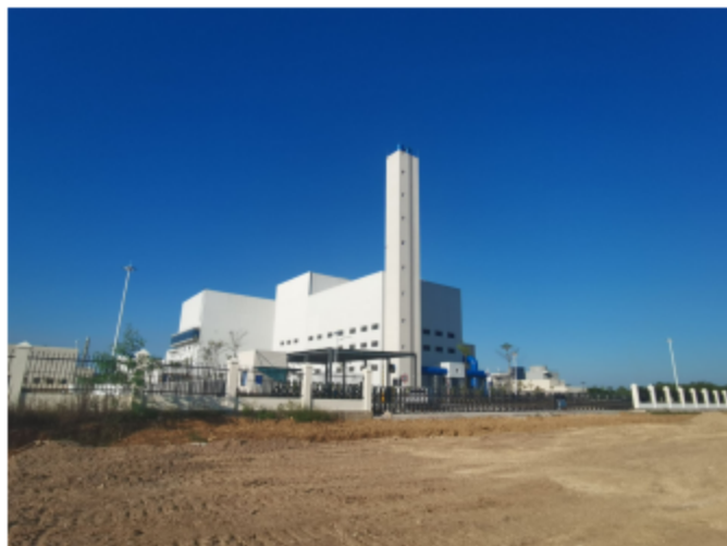
北面相隔创业路的平南县生活垃圾焚烧发电厂
