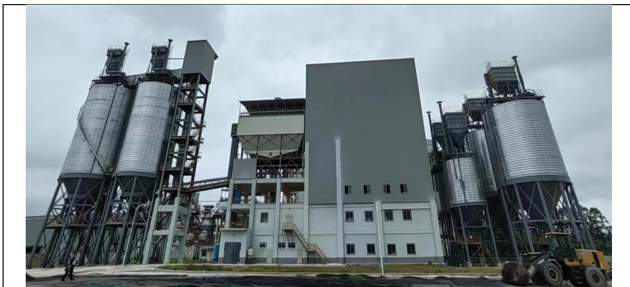
粉煤灰仓、钢渣仓、矿渣仓、产品仓仓顶除尘器、封闭的厂房
