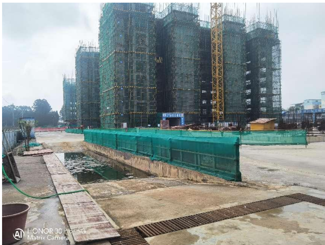
图 3.3-3 目前建设中的照片
