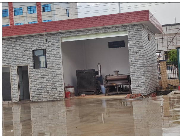
门卫室、发电机房
