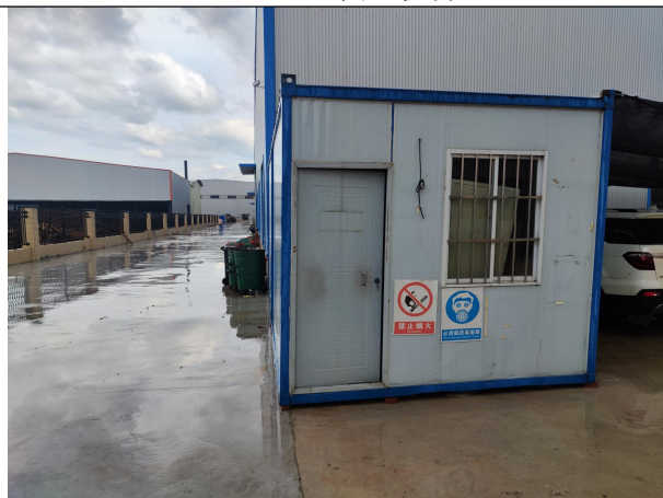
危险废物暂存间
