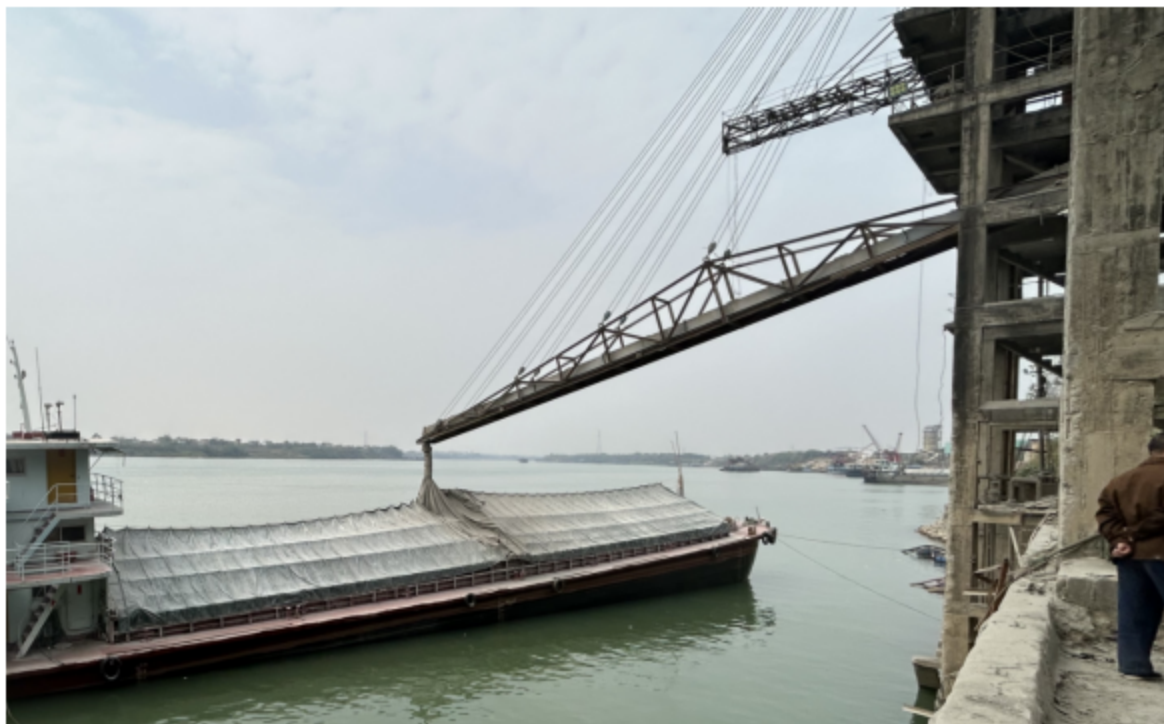
图 2.2-1 现有工程水泥出口装置图
