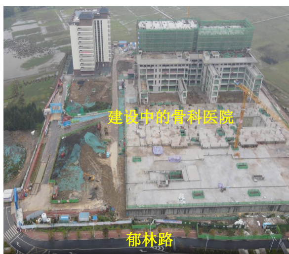
北面现状：建设中的贵港市中西医结合骨科医院、郁林路
