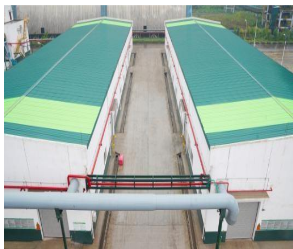
1、2号危废暂存库
