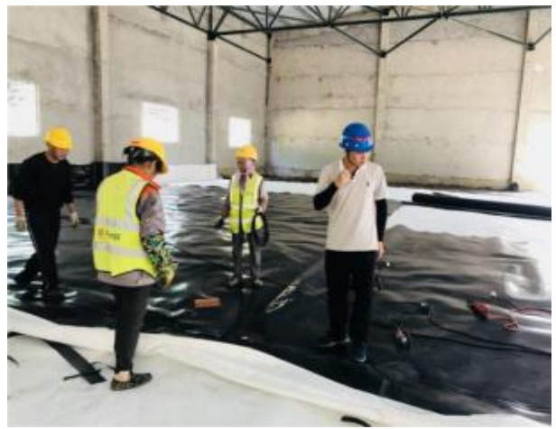
施工现场防渗铺设照片
