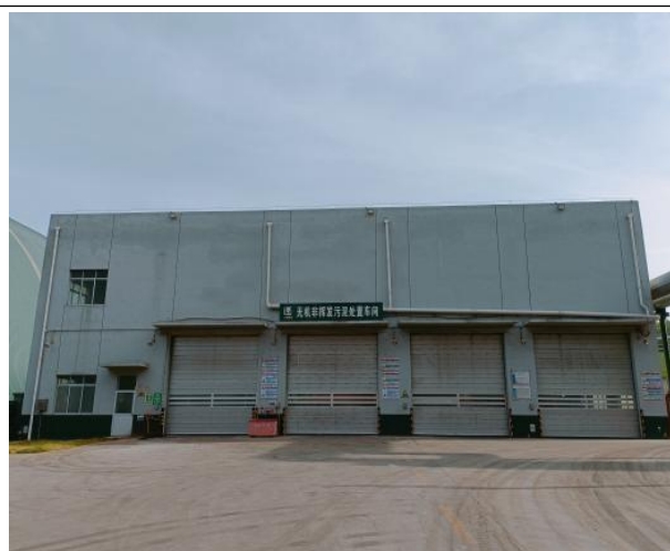
无机危废预处理车间
