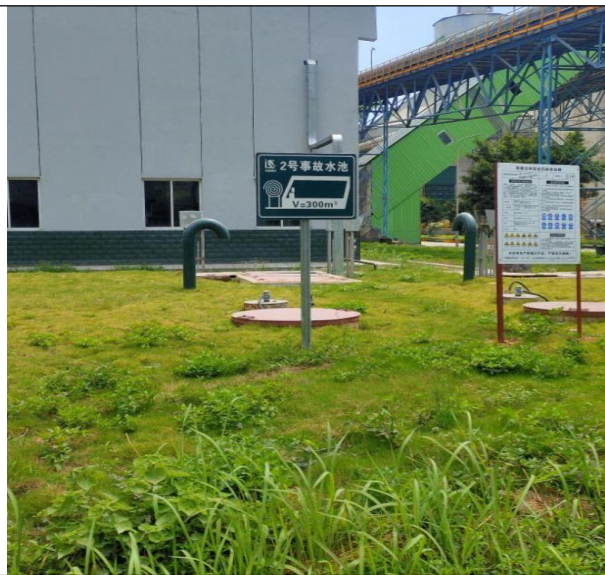
2号事故水池（埋地）
