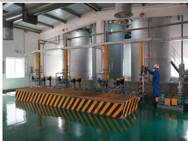
废液车间内部
