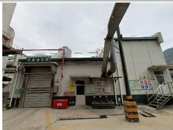
废液车间外部
