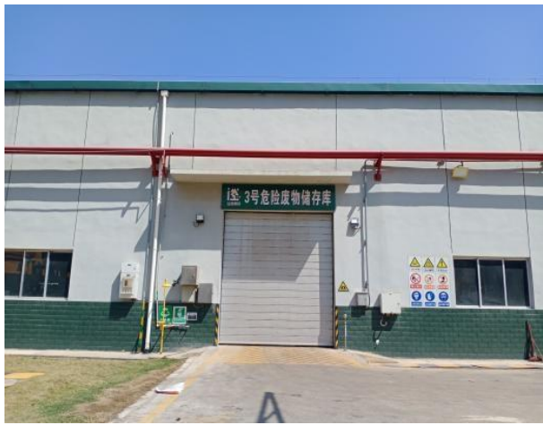
3号危废暂存库
