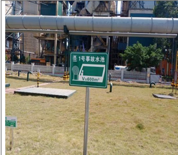
1号事故水池（埋地）
