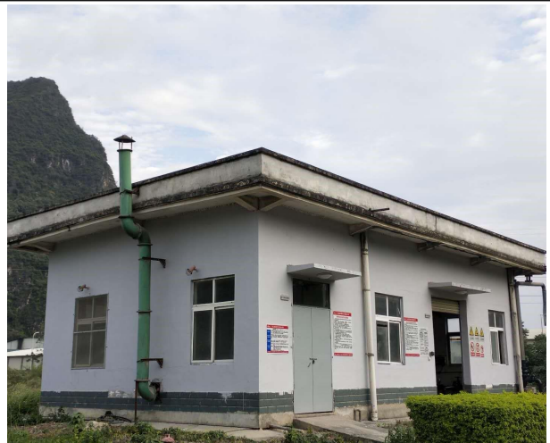
生活区生活污水处理站
